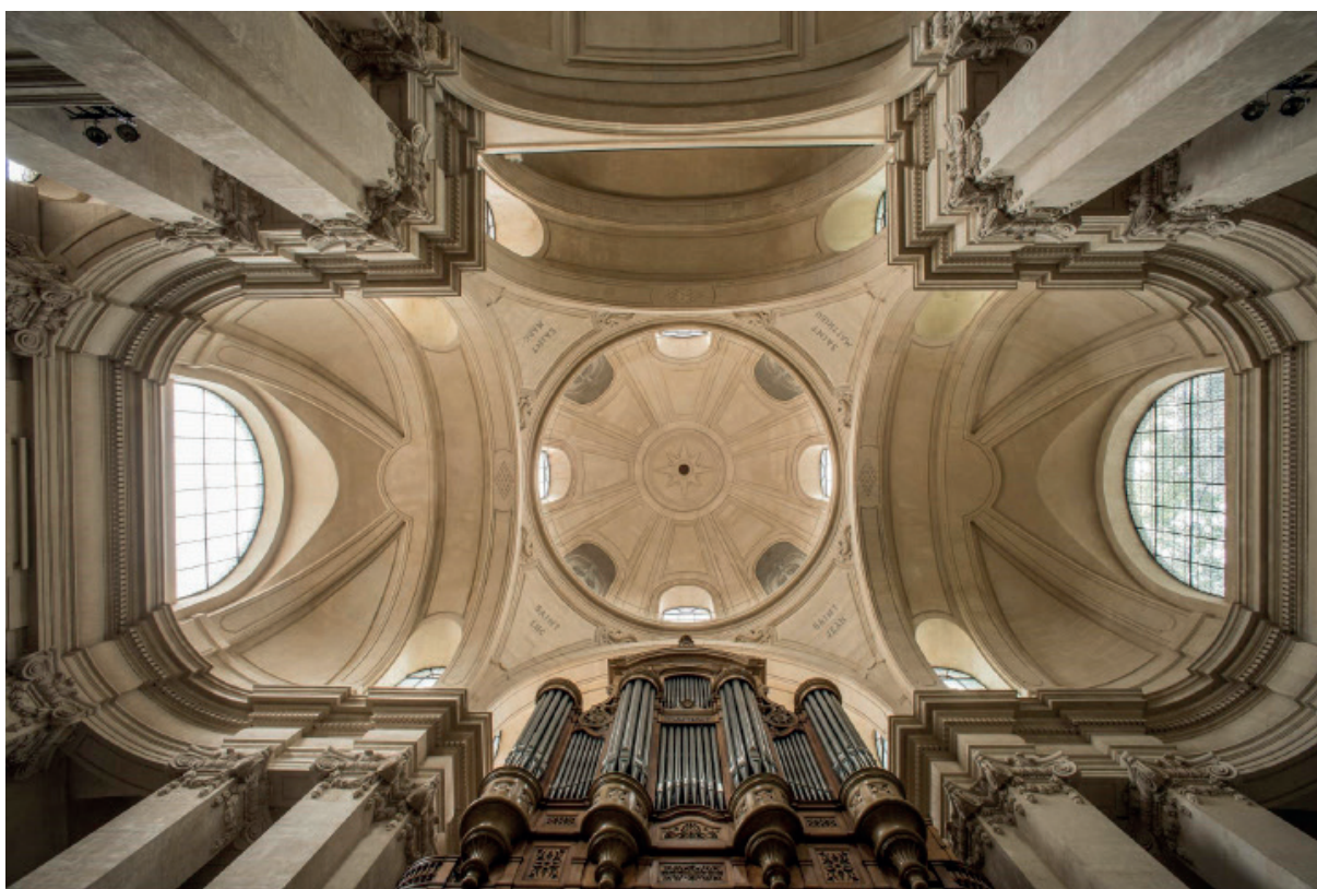
fig. 7 : Le Temple de Penthemont, rue de Grenelle à Paris : vue de la coupole et des voûtes (Cl. Pierre-Louis Laget)
