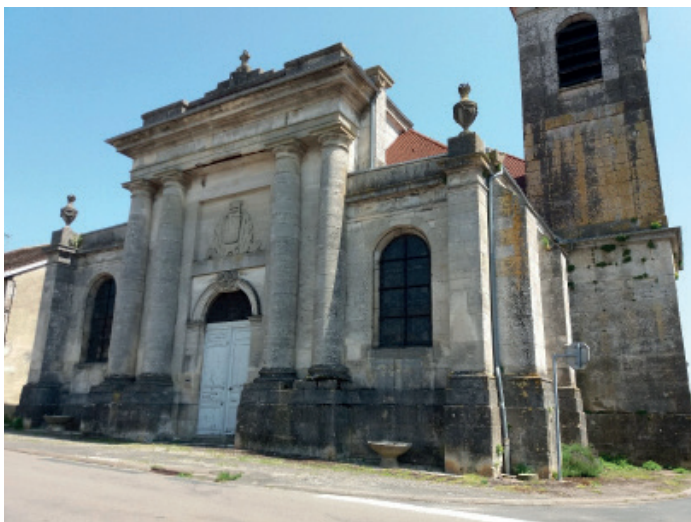
fig. 9 : Reynel, église Notre-Dame-en-son-Assomption, vue de la façade occidentale, et de la tour-clocher, 1779, état actuel.
