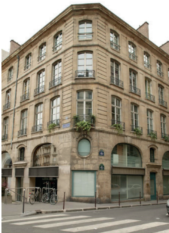
fig. 10 : Immeuble Gouffier à l'angle des rues Hérold et Etienne Marcel, à Paris (Cl. Conseil départemental de l'Essonne)
