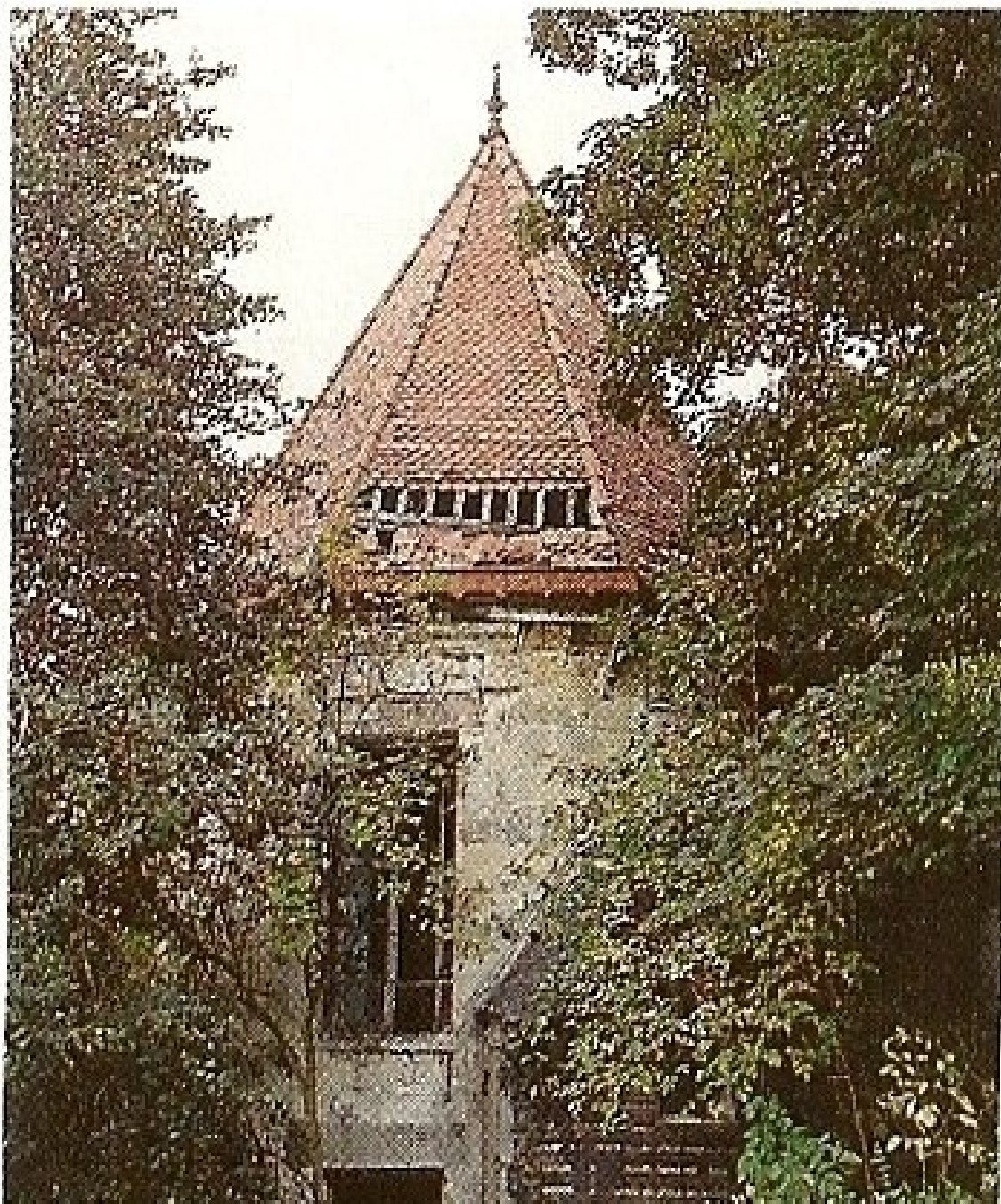
Fig. 18 - Le colombier d'Escures avant la chute de la toiture.
